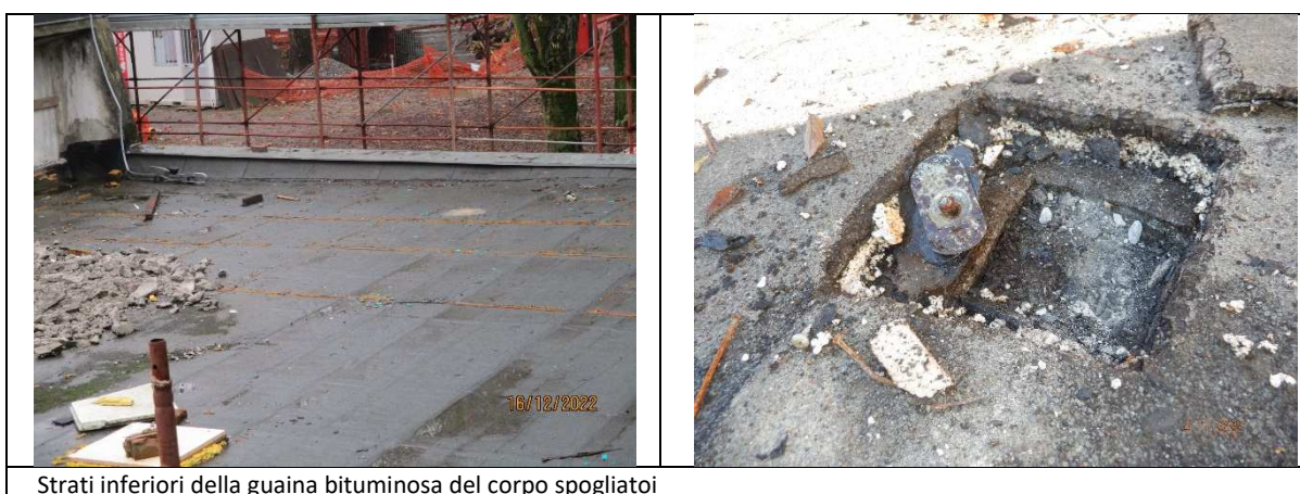
Strati inferiori della guaina bituminosa del corpo spogliatoi
